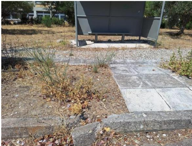
Σημειακή αποκατάσταση σε κράσπεδο – Πρόβλεψη σκάφης ΑμΕΑ
