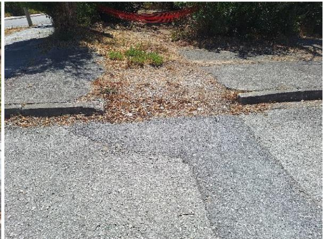
Σημειακή αποκατάσταση σε κράσπεδο – Πρόβλεψη σκάφης ΑμΕΑ
