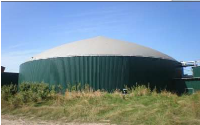
Αναερόβιος χωνευτήρας ενσιρωμένου καλαμποκιού στη Γερμανία
