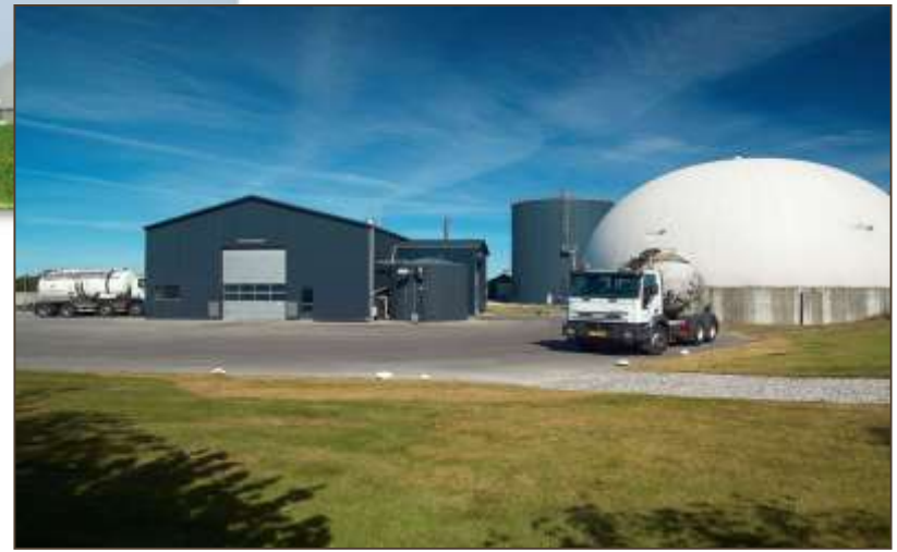
Κεντρική μονάδα επεξεργασίας αποβλήτων βουστασίου στη Δανία
